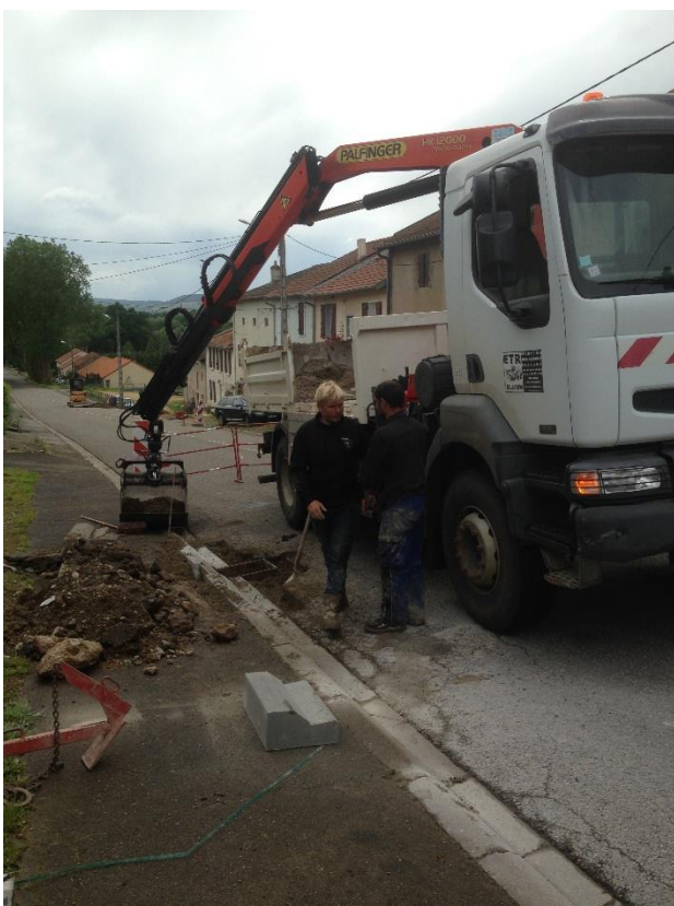
Le 15 juin, réparation de plusieurs avaloirs et de la conduite d'assainissement.
