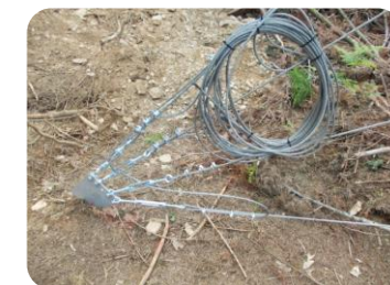
Ancrage des haubans au sol
